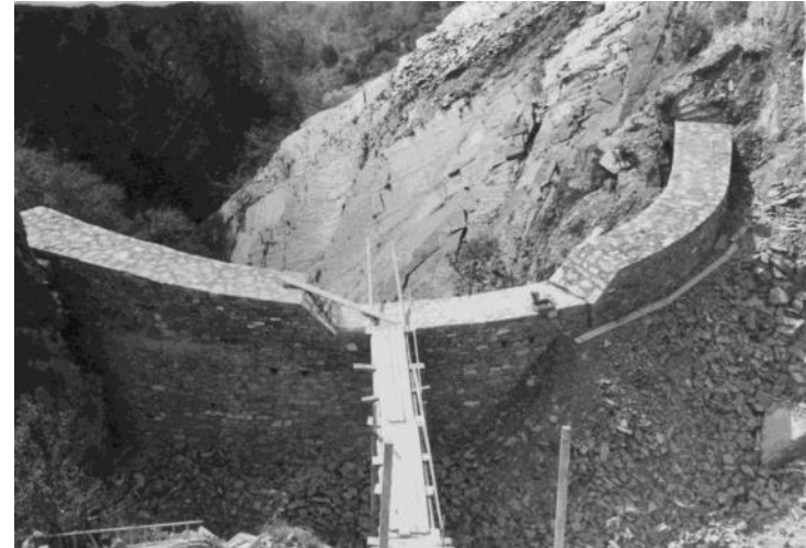
Briglia ad arco Torrente Crovana (Sp). 1960 ca. La stessa nel 2002
